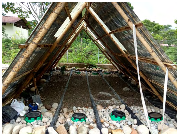
Figura 2 | Sistema de filtración granular dividido en cuatro canales, y cubierto para evitar ingreso de aguas lluvias, como tratamiento secundario de la planta piloto para tratamiento de aguas residuales en la Universidad Regional Amazónica Ikiam (Ecuador).
